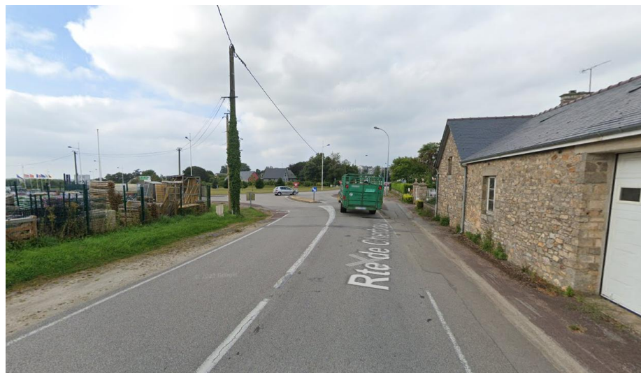
Aménagements piétons sur la route de Cherbourg au nord de notre secteur d'étude – Street View google maps
