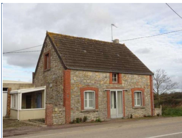
Photo 3 : Habitation 2 au lieu-dit « Bellevue »
