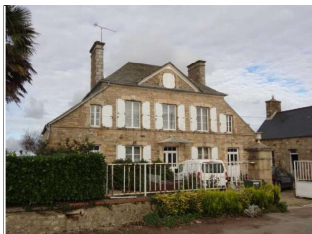
Photo 2 : Habitation 1 au lieu-dit « Bellevue »
