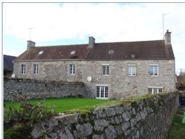
Photo 4 : Habitation 1 au lieu-dit « Etang Val »
