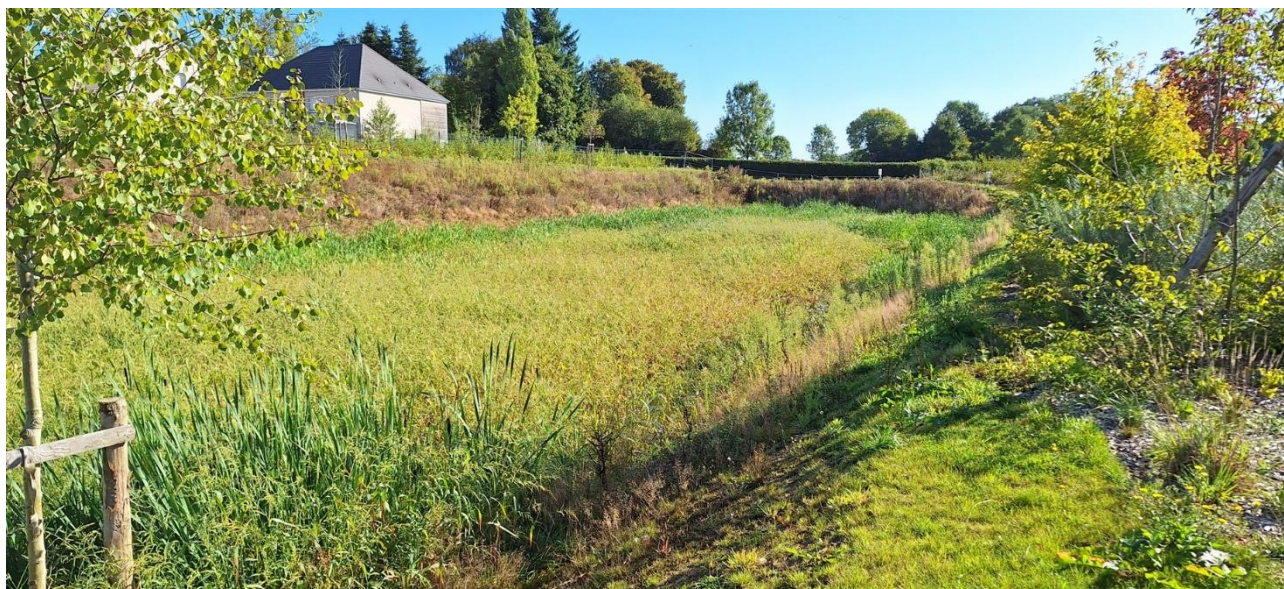
Un bassin de rétention des eaux pluviales
