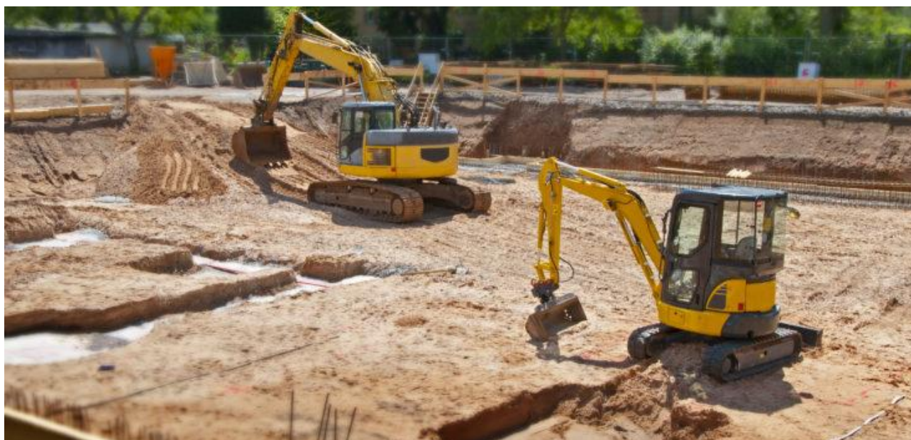
Un chantier de terrassement
